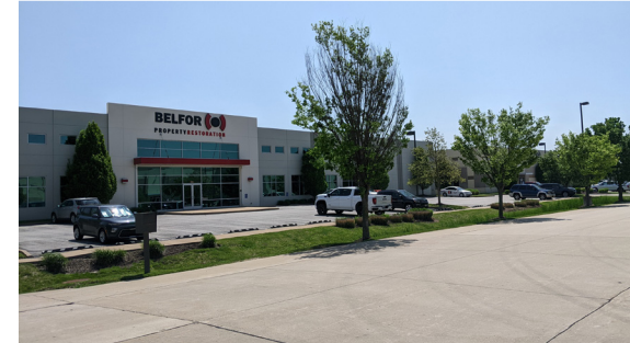
D1. SW CORNER, FACING NE
